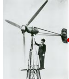
Ο Marcellus Jacobs πάνω σε μία ανεμογεννήτρια 1940-50 (ισχύς ~3 kW)
